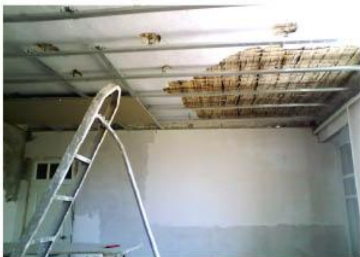
Фото 23. Дитячий садочок до ремонту, с. Новобогданівка
